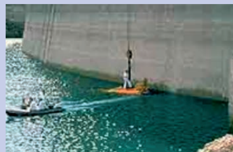
Visite décennale du barrage de Bimont avec inspection subaquatique par sous-marin.
