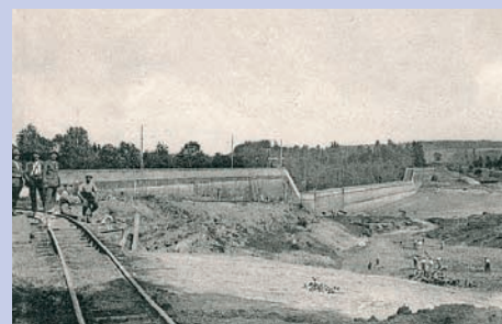
La rupture du barrage de Bouzey, en 1895. Ci-dessus, les ruines et les dégâts. Ci-dessous, la reconstruction.
