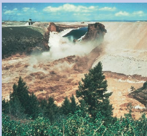
Rupture de barrage en terre. Le barrage de Teton (Idaho, États-Unis, 1976).
