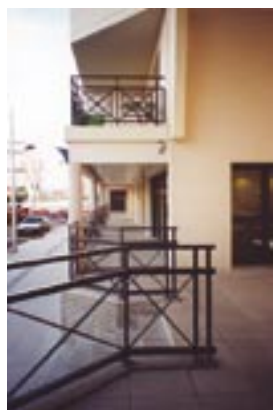
Îlot n°2. Le niveau du rez-de-chaussée est à 50 cm au-dessus du niveau de la crue de 1995 [Roseline Quiko, CETE Normandie Centre]
