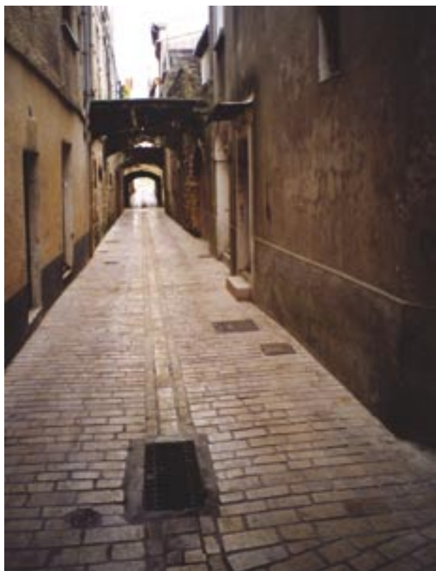
Caniveau axial et soubassement renforcé [CETE Méditerranée]
