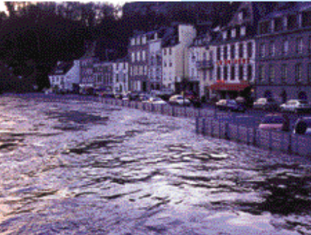
Barrières anti-crues sur le Quai Briseux
